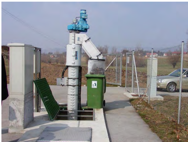
Slika 3.1.2.2.-3.: Vertikalna rešetka u funkciji.
